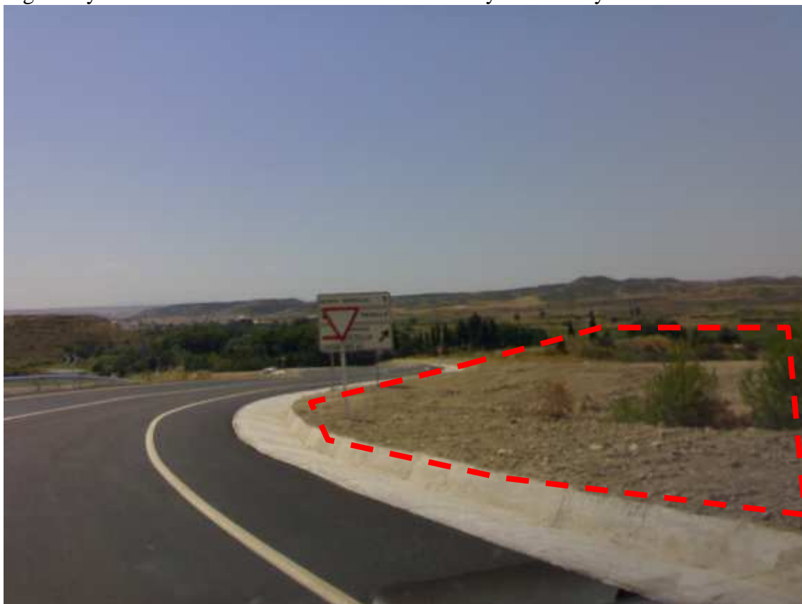
Figura 3 y 4: Señalización del cruce desde NA-6020 y NA-6100 y desmante
