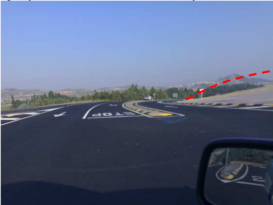
Figura 1 y 2: Visibilidad desde el cruce, desmonte en líneas rojas discontinuas
